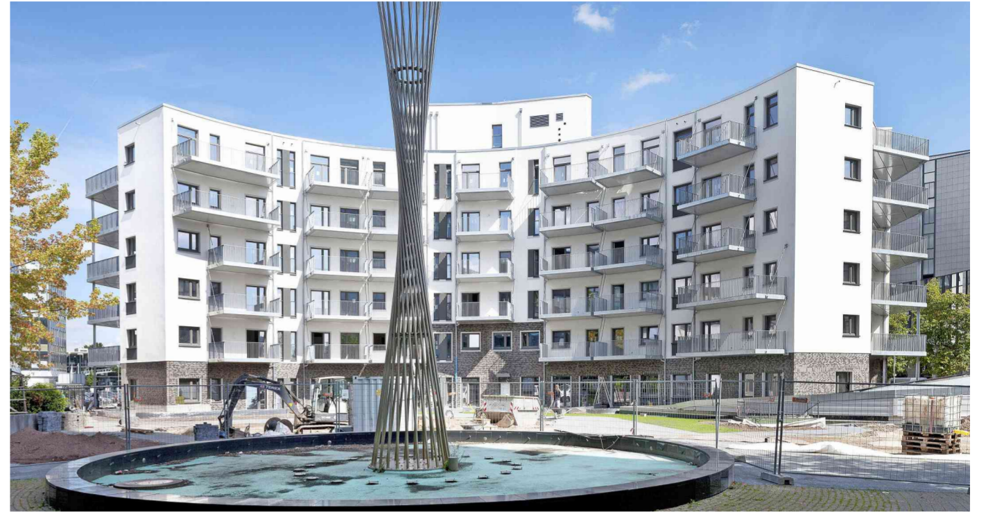
Nachher: Im zum Wohnhaus umgebauten „Living Circle“ sind Mietwohnungen für 1300 Bewohner entstanden.
