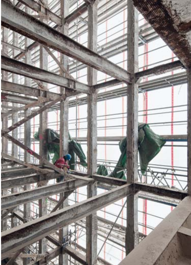
Das Gerling-Hochhaus wurde 1953 in damals innovativer Stahlskelettbauweise errichtet. Die Fassade aus Muschelkalk und Naturstein wird vom Kölner Büro ksg derzeit subtil saniert.
