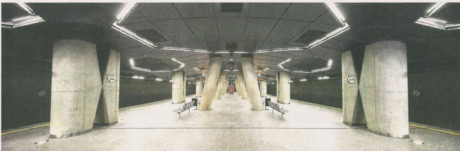
Severinsstraße: Auf dem von Johannes Kister entworfenen Bahnsteig dürfen sich betonierte Zwillingstützen wie zum Kuss berühren.
