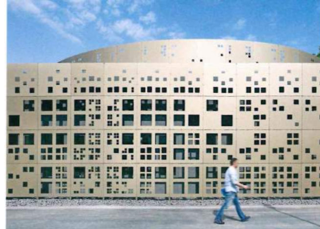
Unzählige quadratische Öffnungen bieten vielfältige Ein- und Ausblicke.
