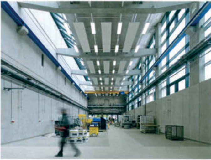
oben und rechts Die Deckenträger lagern nicht auf der Wand, sondern sind hängend mit ihr verbunden
