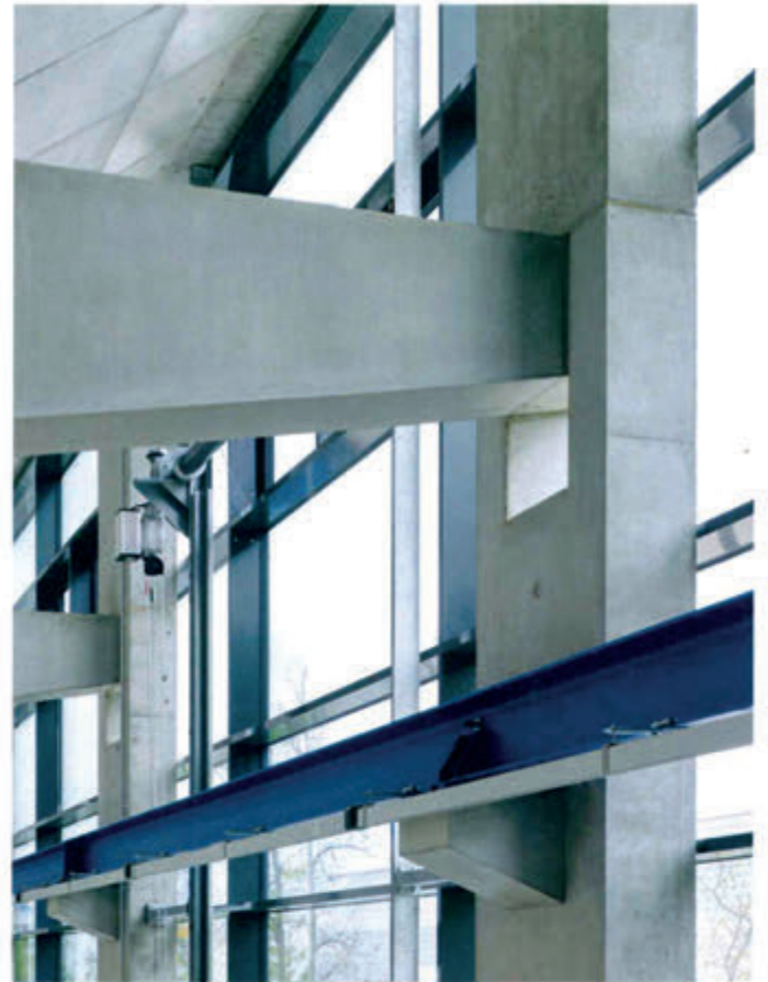
oben und rechts Die Deckenträger lagern nicht auf der Wand, sondern sind hängend mit ihr verbunden
