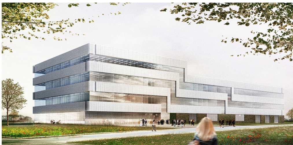
Unterschiedliche Geschosshöhen und eine modulare Fassade bestimmen das äußere Bild. (© ksg)
