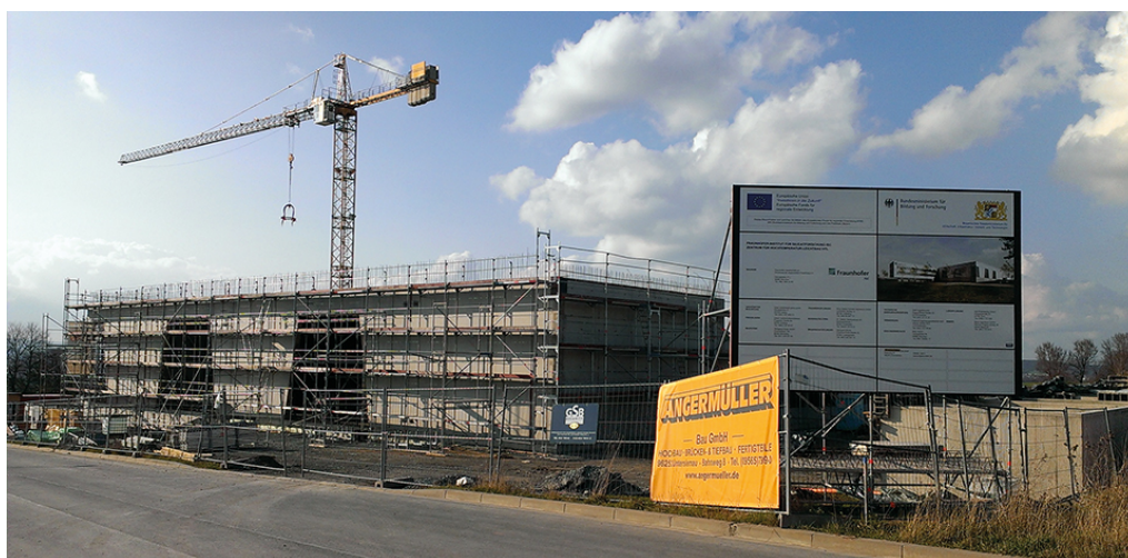
Hier entstehen 2.600 m 2 für Laborräume, Werkstätten und Büroräume. © S. Kuballa, Fraunhofer HTL
