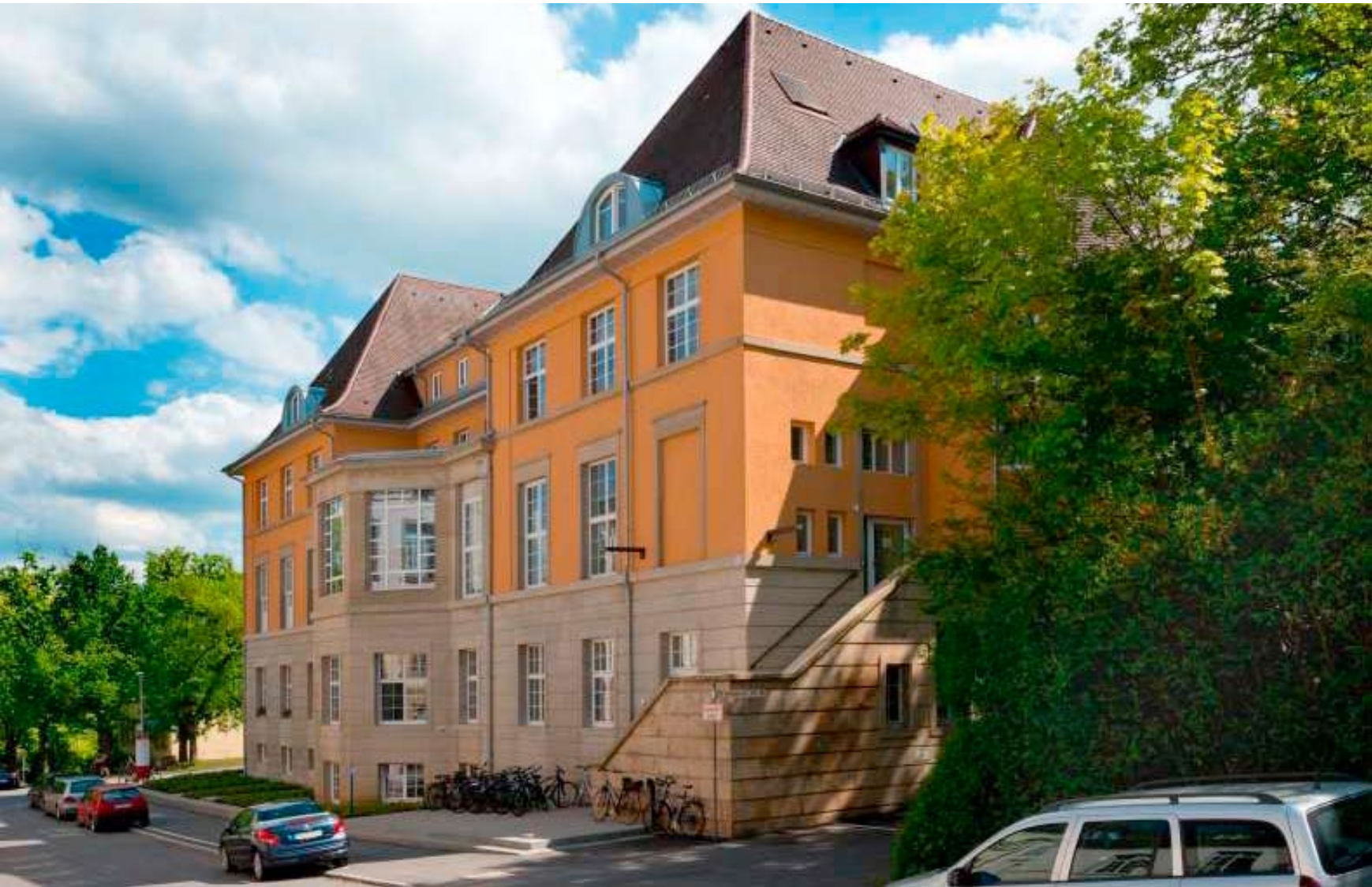
1911 wurde der Hauptbau durch ein u-förmiges Gebäude ergänzt. Beide Abschnitte wurden nun saniert. Vor allem die Fenster mussten rekonstruiert oder saniert werden.
