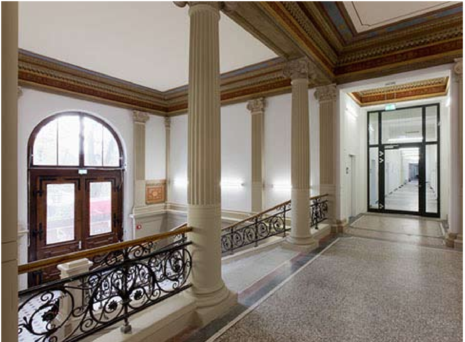
Der originale Steinboden im Eingangsbereich war ebenso in einem guten Zustand wie die lange Zeit unter einem PVC-Boden verborgenen Terrazzoflächen in den Fluren.
