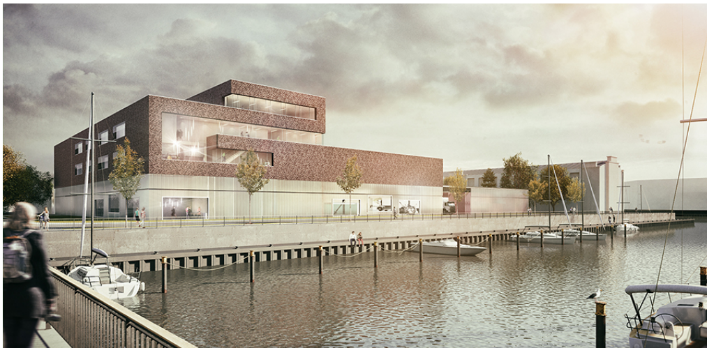
Dem Wasser zeigt sich der skulpturale Neubau mit einer klaren Kante. (© ksg / rendertaxi)
