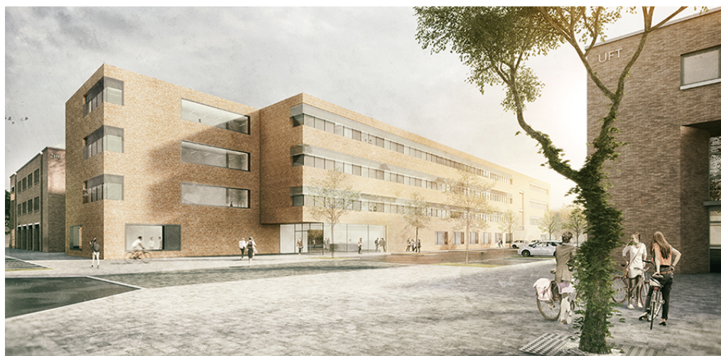
Der helle rot-beige Ziegel mit geschlossenen Fugen frischt die dunkleren der Umgebung auf. (© ksg)
