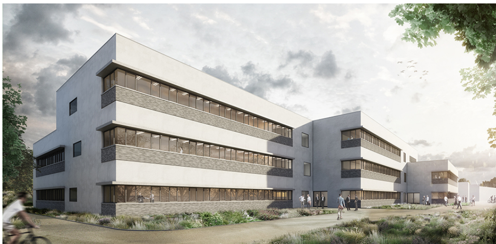
Die dunklen Fensterbänder stehen im Kontrast zu dem hellen Baukörper des Laborneubaus. (© ksg)
