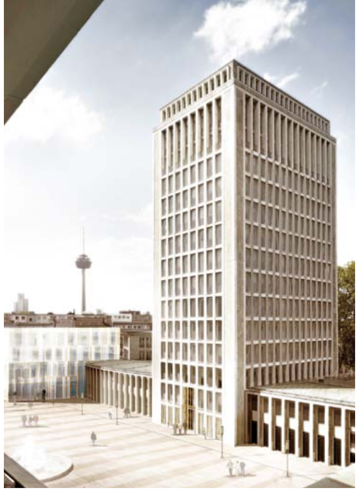
Das Gerling-Hochhaus wurde 1953 in damals innovativer Stahlskelettbauweise errichtet. Die Fassade aus Muschelkalk und Naturstein wird vom Kölner Büro ksg derzeit subtil saniert.
