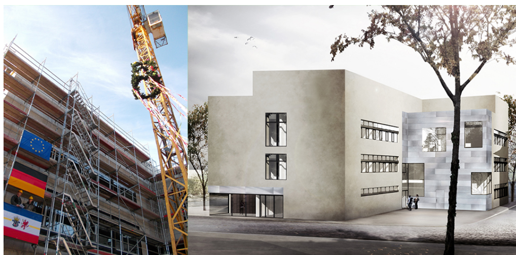
Das neue Laborgebäude beim Richtfest am 20. Februar sowie in der Visualisierung. (ksg)
