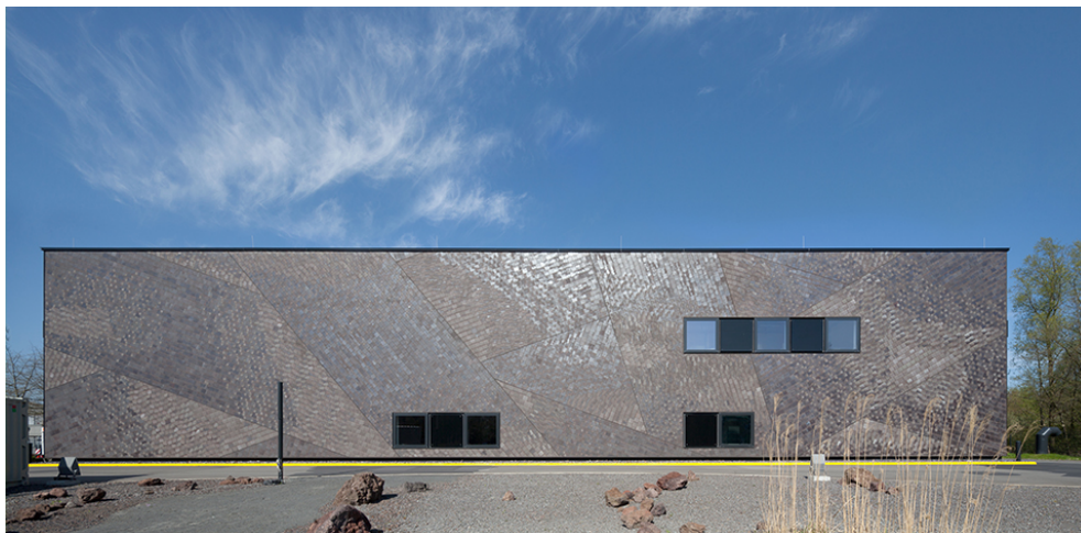
Das DLR-Forschungsgebäude „SpaceLIFT“ beeindruckt durch seine Spaceshuttle-Fassade. (Foto: Y. Zerdoun)
