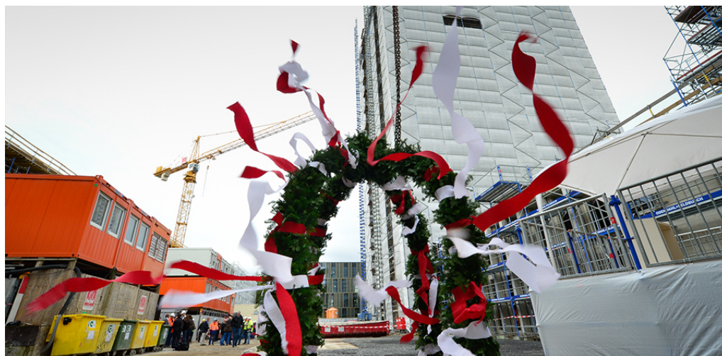
Heute wurde im Gerling-Quartier Richtfest gefeiert. (Foto: IMMOFINANZ Group)
