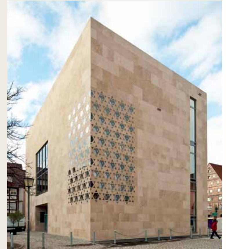
Das Eckfenster umfasst eine Fläche von insgesamt 2 x 4,2 x 8,5 m.
